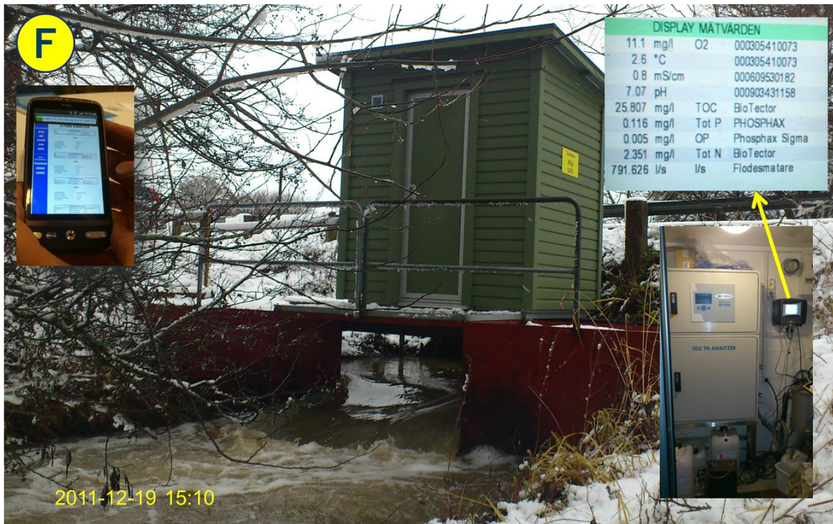
Figur 24 Mätpunkt F 2011-12-19 15:10. Infällda är foton på den mobila terminalen samt interiören i mätboden och detalj på displayen för realtidsdata. Passagen för vattnet under boden är utformad för att ge vattenflödet som en funktion av vattenståndet i Märstaån vid bodens placering. Vid ett besök den 19/12 2011 kl 15:10 är flödet 791,6 l/s, syrehalten 11,1 mg/l, temperaturen 2,6 C, TOC (Total Organic Carbon) 25,8 mg/l, Total Fosfor 0,116 mg/l och Total kväve 2,351 mg/l.
