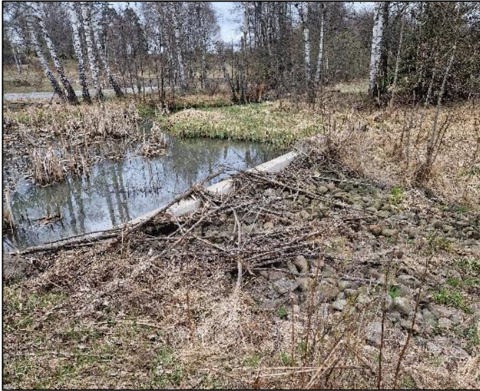
Figur 4.25 Överfall vid Rosersbergsbäcken där ytvatten kan brädda till Moralundstunneln.
