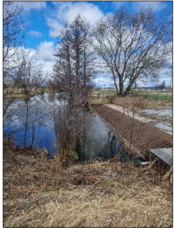
Figur 4.19 Gallerförsedd inlopp till Moralundstunneln från Fältvägsdammen (Måby vattenpark).
