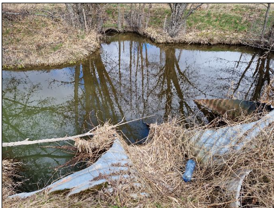
Figur 4.16 Sammanflödet av Odensalabäcken och Märstaåns övre del. Odensalabäckens vatten kommer från vänster i bild och vattnet från höger kommer från provpunkt F. Tre trummor (varav två syns i närmast i bild) leder vattnet vidare till Måby vattenpark. På motstående sida syns en inbuktning i strandlinjen med en trumma som avleder dagvatten från Märsta samhälles nordöstra del, se tekniskt avrinningsområde i Figur 4.17.
