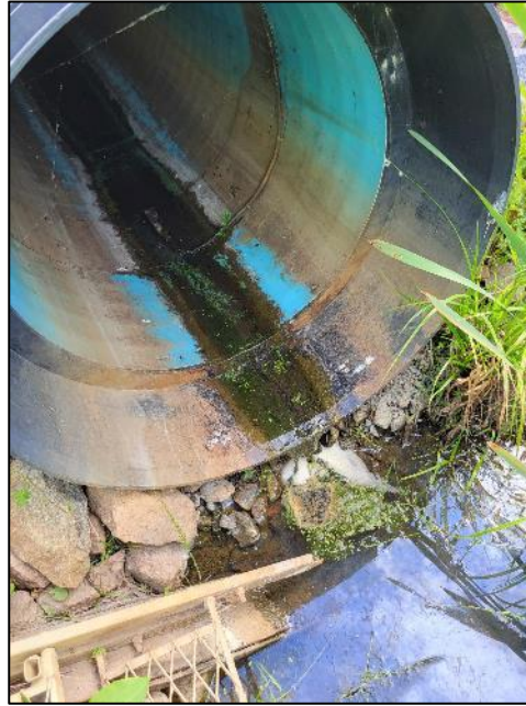
Figur 4.10 Utloppsledningen för KDA ut och KDA bypass.
