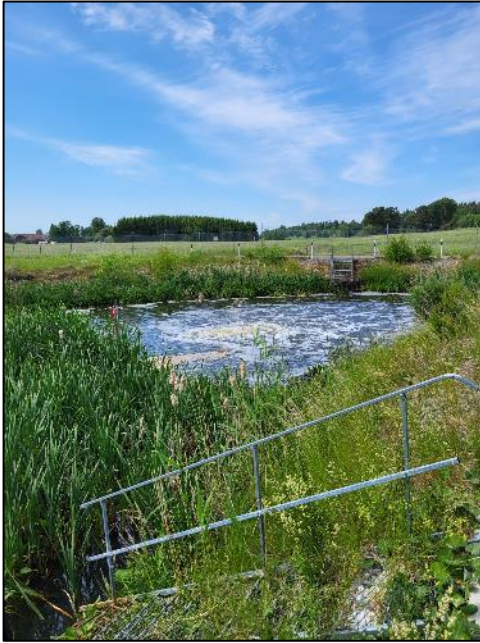
Figur 4.9 Luftningsdamm precis nedströms KDA ut och KDA bypass.
