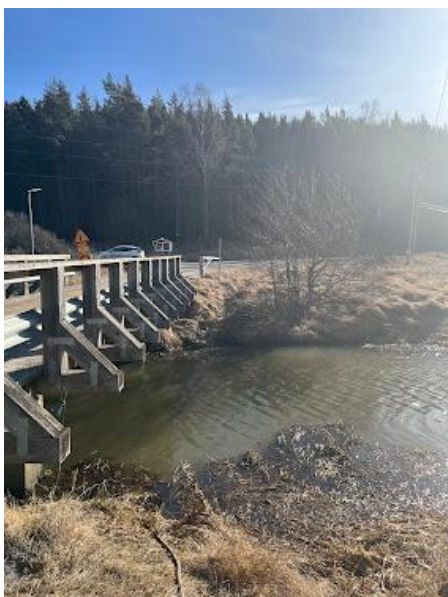
Figur D8: Provpplats "Märstaåns utlopp"
